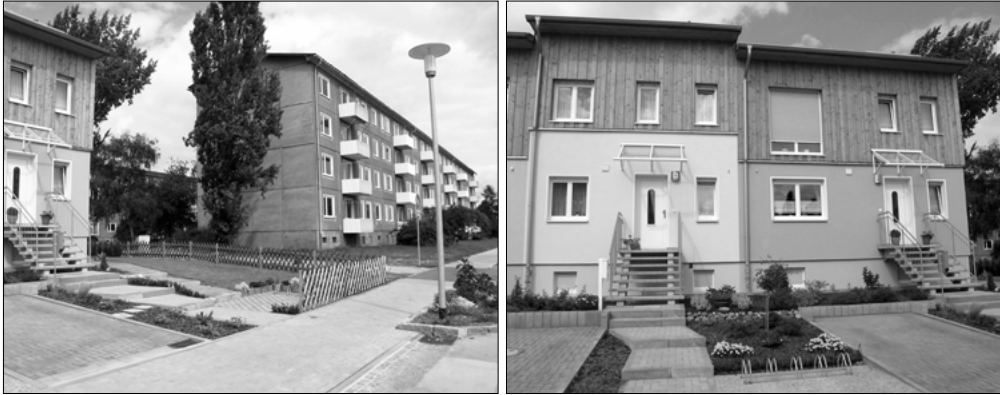
Abbildung 4: Gebäude im Ursprungszustand und zu Reihenhäusern umgebauter Bestand in Lübbenau
